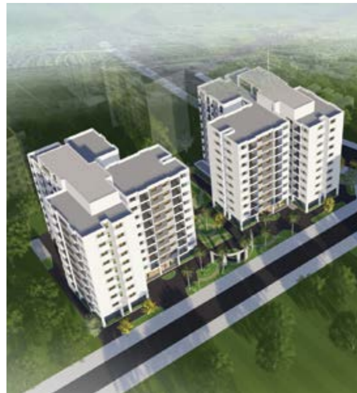
Dự án: CT2 Bộ tư lệnh Thủ đô Project: CT2 Capital Command
